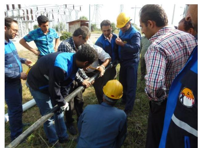
این کلاس آموزشی که بخش اول عملی دوره فوق بود در ایستگاه ۲۳۰ کیلوولت ساری به مدت ۸ ساعت برگزار شد. در این بخش کارشناسان تانش با نحوه تشخیص رطوبت‌زدگی کابل ۶۳ کیلوولت بصورت عملی آشنا شدند. در ادامه با قیارندود کردن سر کابلها جهت جلوگیری از رطوبت زدگی و در پایان با نحوه دفن صحیح کابلهای ۶۳ کیلوولت آشنا شدند و بصورت عملی این موارد را انجام دادند. در بخش سوم که در مهر ماه برگزار خواهد شد، نحوه سرکابل زنی بصورت عملی تدریس می شود. لازم به توضیح است که دوره نظری قبلاً به مدت ۱۶ ساعت برگزار شده بود.
